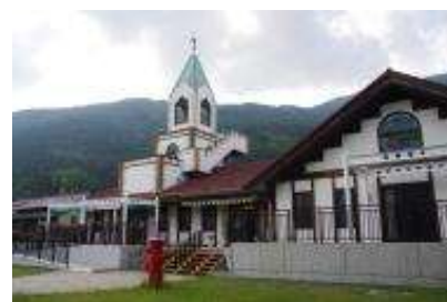
南アルプス井川観光会館
