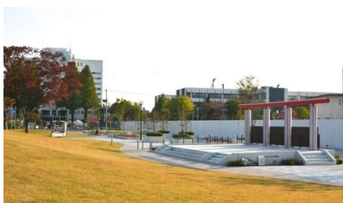
【コンクリート製 野外ステージ】
