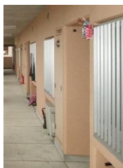
共用廊下側の窓面格子
