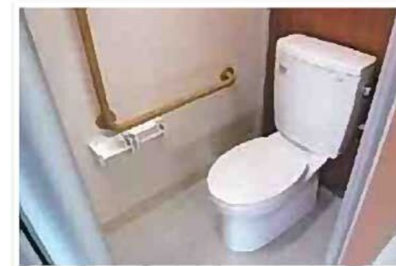
改修後のトイレ
