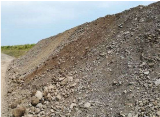
写真③ サジーの植え付けが予定される防潮堤法面, 植物の生育にはかなり過酷な状況
