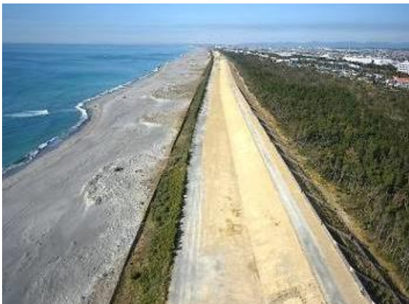
浜松市沿岸域防潮堤
