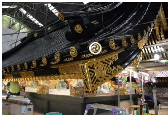
静岡浅間神社社殿の修復
