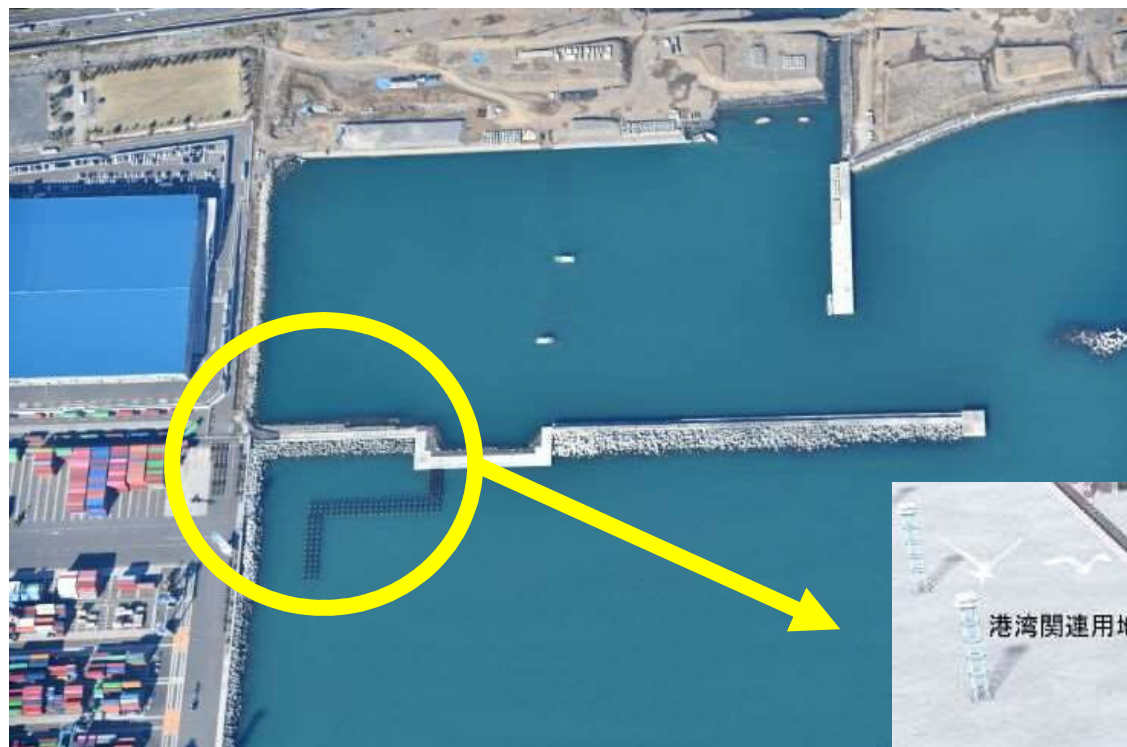
令和3年12月現在の海づり公園航空写真
