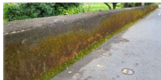
現状の写真(既設防潮堤)
