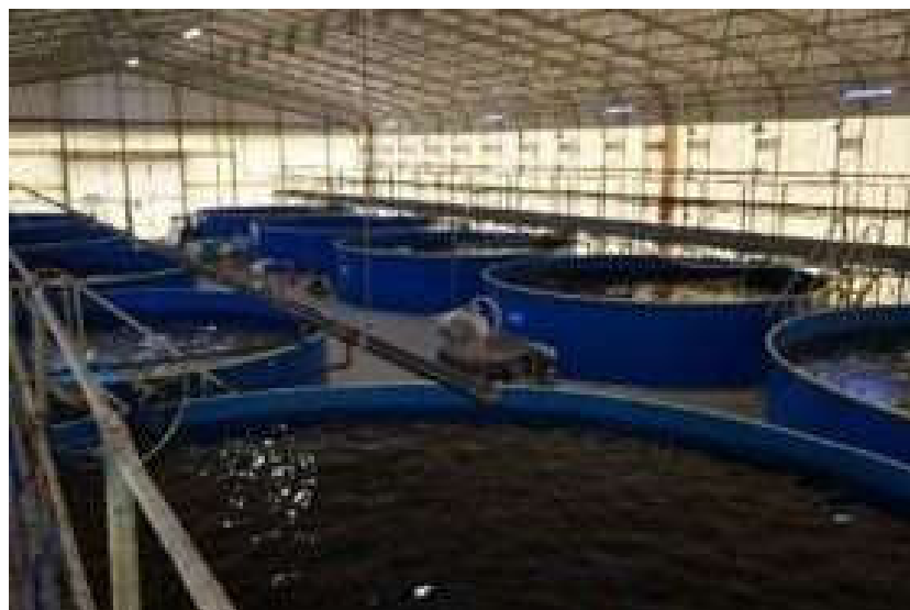
▲陸上養殖場内部の様子
