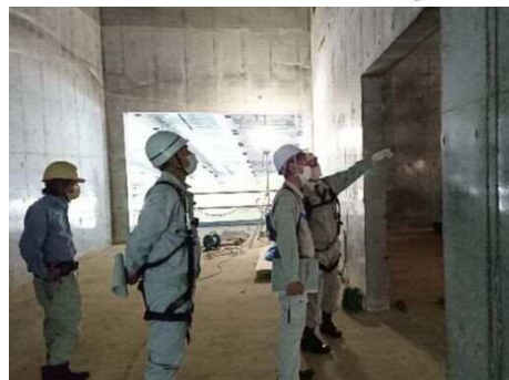
仮称静岡市歴史文化施設建築工事
