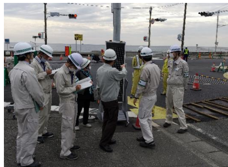
(国) 150号久能拡幅(根古屋)道路改良工事
