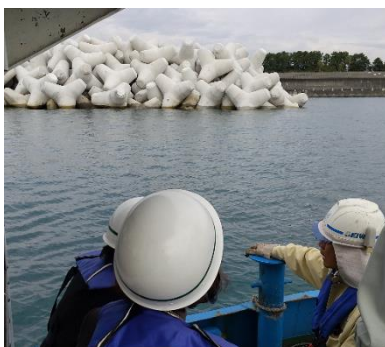
用宗漁港広野防波堤災害復旧工事
