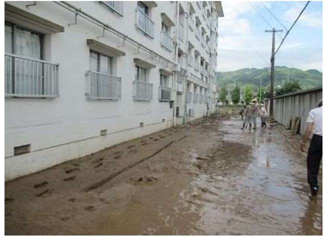
【写真⑧】 清水高部団地 (清水区石川新町)の被災状況
