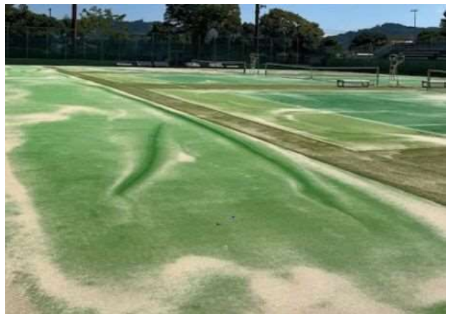
【写真⑥】 西ヶ谷総合運動場 （葵区西ヶ谷）の被災状況
