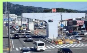
国道1号静岡バイパス(清水立体)
