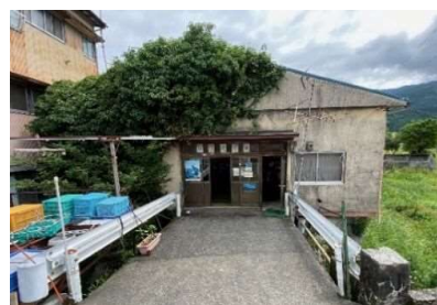
現) 待合所(1959年建築・62年経過)
