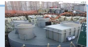
従来の耐震性貯水槽(埋設中)
