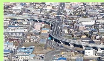
150号静岡バイパス(中島高架橋)
