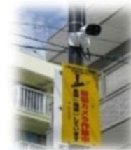
街頭防犯カメラ 設置状況
