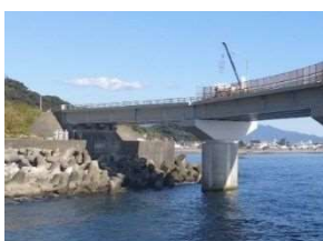
道路橋耐震化事業(橋脚巻立て)
