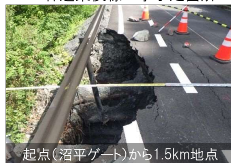
R4 林道東俣線工事予定箇所
