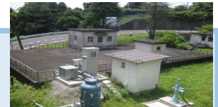
蒲原城山配水池
