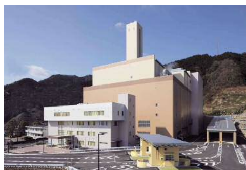
西ヶ谷清掃工場
