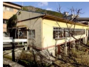
【現況写真】 井川湖渡船待合所 （1959年建築、 61年経過）
