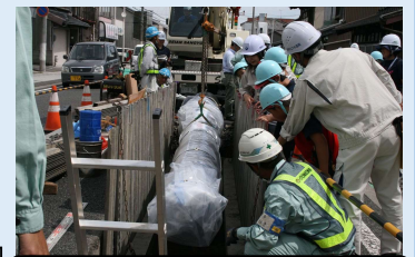
老朽管の更新
