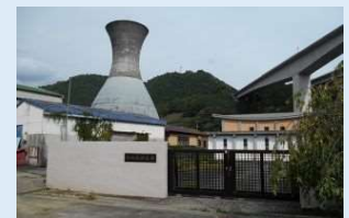
和田島浄水場
