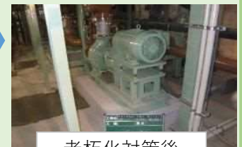
老朽化対策後
