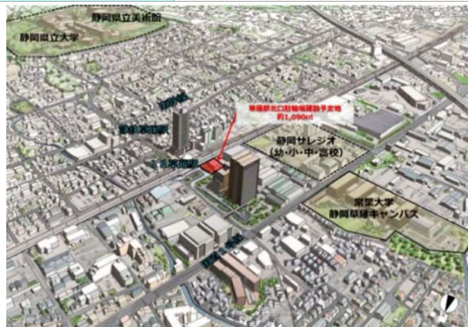
J R 草薙駅北口駐輪場建設予定地
