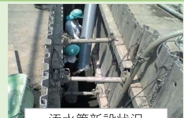
汚水管新設状況
