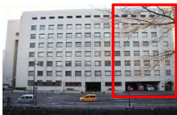
葵消防署庁舎
