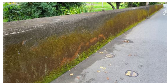
現状の写真(既設防潮堤)
