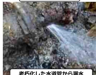
老朽化した水道管
