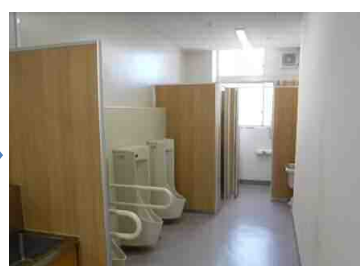
トイレ改修後(例)
