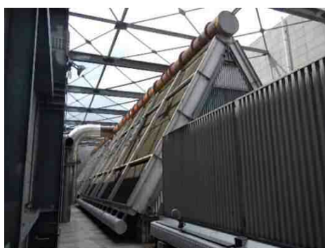
低圧蒸気復水器
