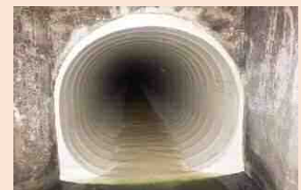
内面を補強した後の下水道管
