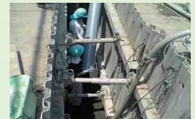
下水道管の整備
