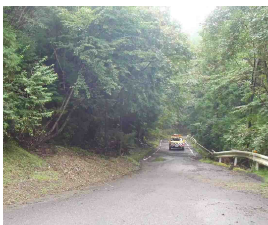
（主）南アルプス公園線（葵区横沢） 過去の降雨等の影響により発生した変状の拡大を防止するため、法面对策を実施
