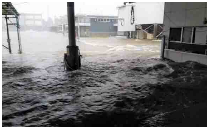
台風19号による浸水被害 (令和元年10月12日)
