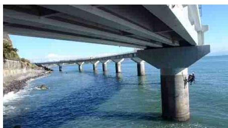
(県) 静岡焼津線 石部海上橋
