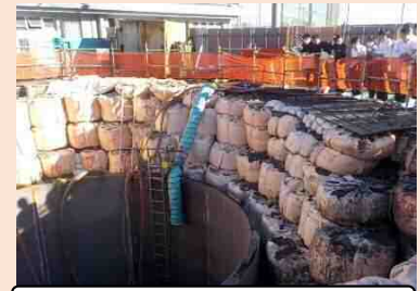
耐震性貯水槽の設置
