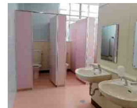
トイレ改修例
