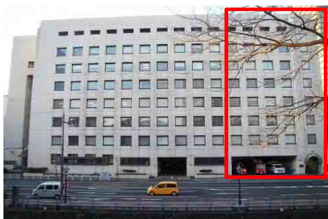
葵消防署庁舎
