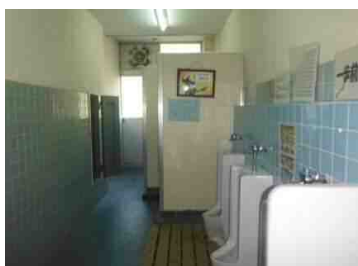
トイレ改修前(例)
