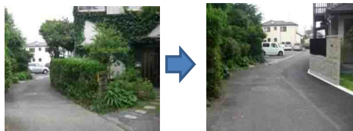
狭あい道路拡幅整備事業 【実施前】 【実施後】
