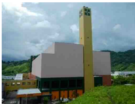
沼上清掃工場全景
