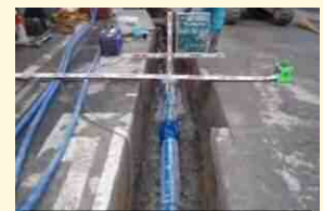
水道管の布設
