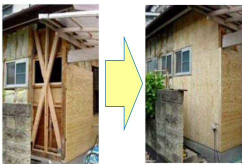
木造住宅の耐震補強工事
