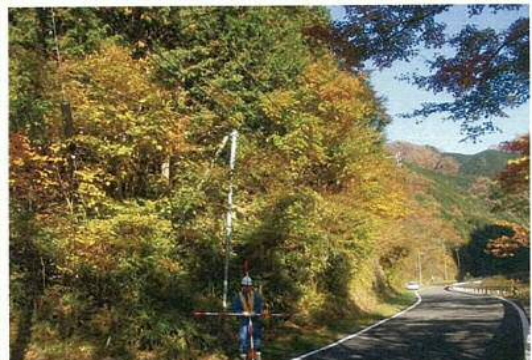
法面点検の様子
