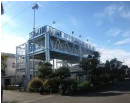
津波避難タワー
