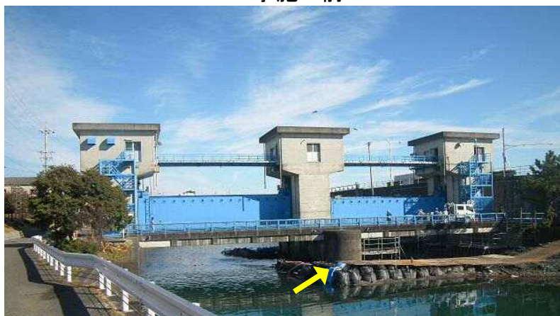
H26工事施工中(右岸側)
