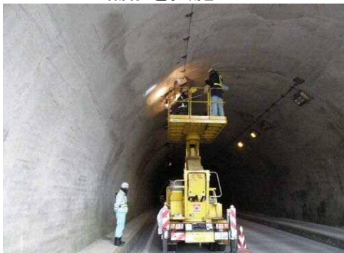
トンネル点検実施個所の例
