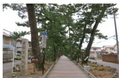
既に神の道に設置されているボードウォーク
