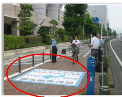
安全な走行空間へ 誘導する路面シール
