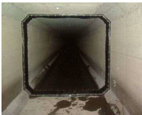
場内配管への可とう性継ぎ手の設置
