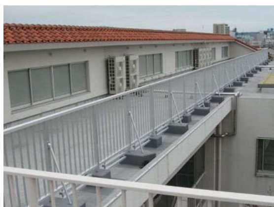
屋上フェンス
