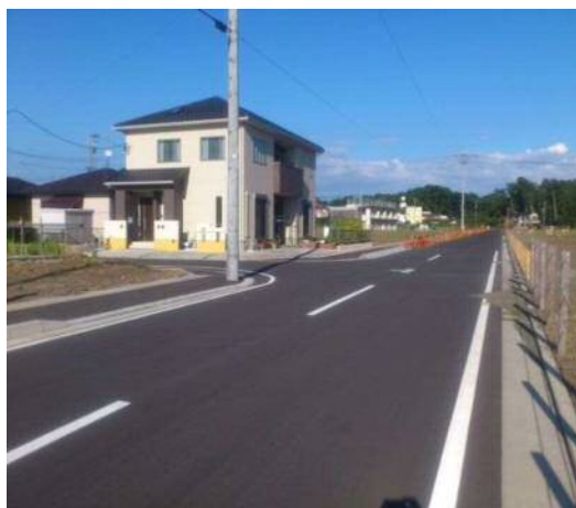
三保羽衣地区：新設の区画道路
