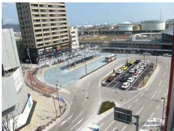
清水駅西口駅前広場完成
