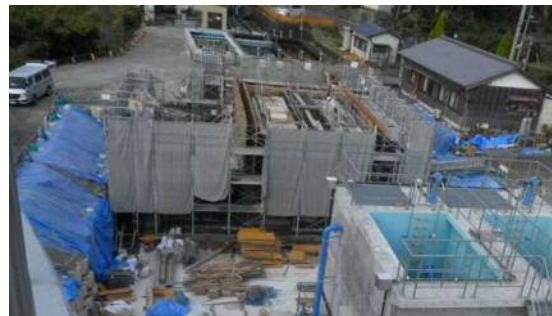
由比第1浄水場改修工事施工状況
