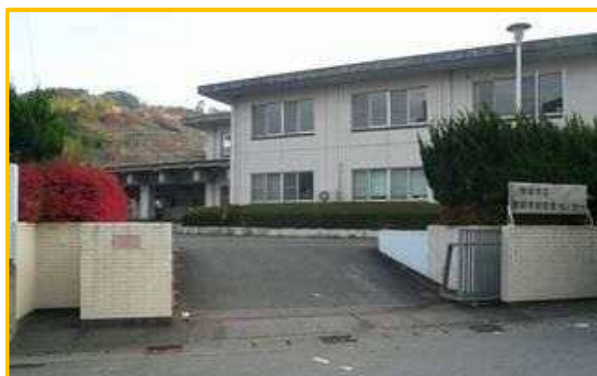
西部学校給食センター (現況)
