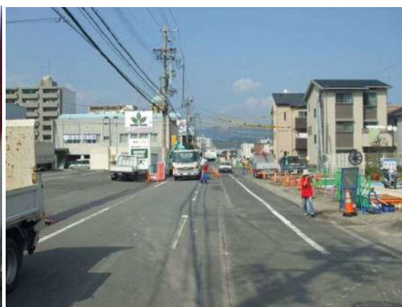
街路築造工事
