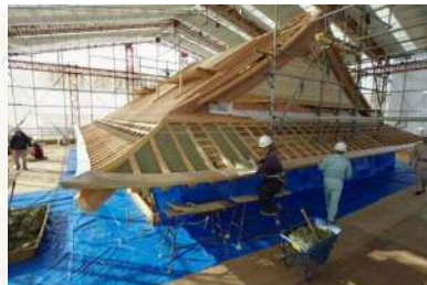
坤櫓建設工事現場
