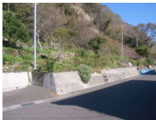
大谷地区：事業区域に隣接する法面
