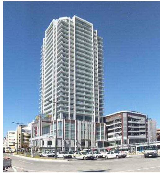
清水駅西第一地区
