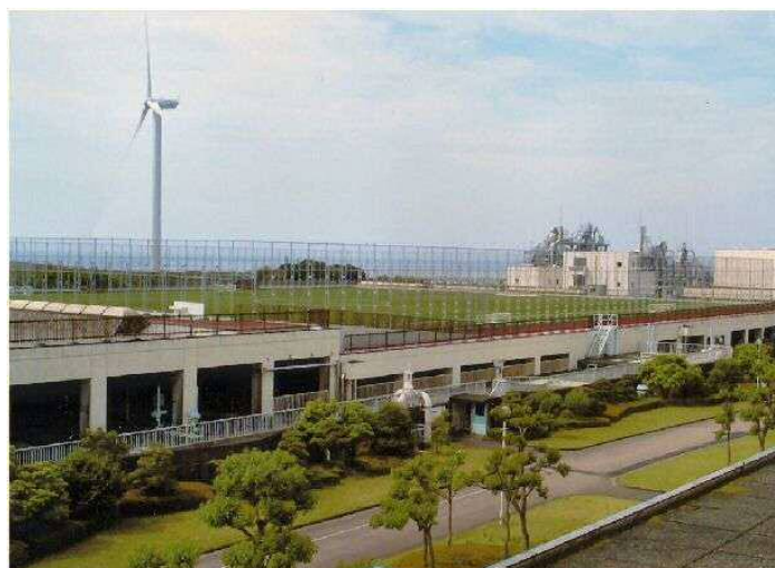
6 下水道施設の耐震化（処理施設）を実施する中島浄化センター
