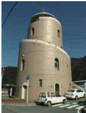
三重県大紀町 (鉄筋コンクリート造)
