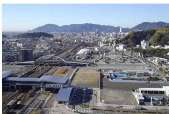
街路築造工事（柚木地区）
