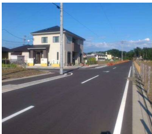
三保羽衣地区：新設の区画道路
