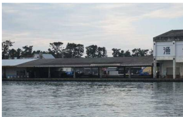
現在の用宗漁港内港西岸壁荷捌所
