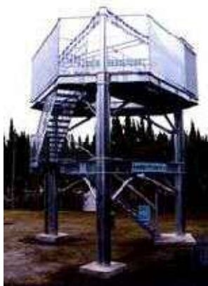
三重県志摩市 (鉄骨造)
