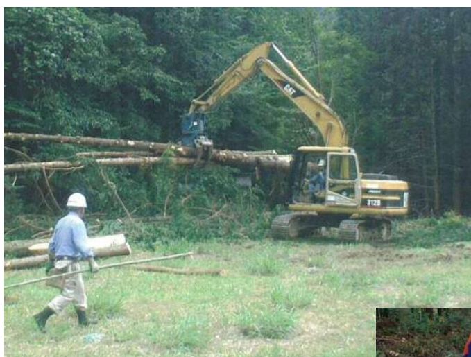
大型作業機械の導入
