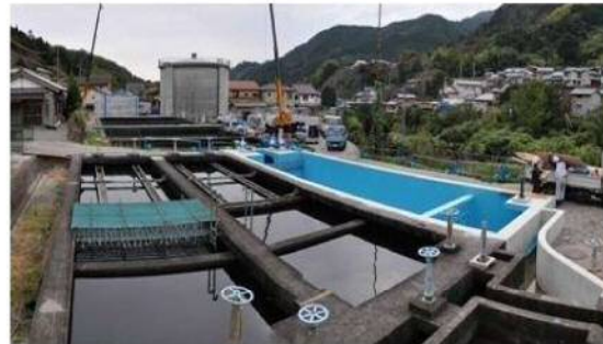
由比第1浄水場改修工事施工状況 (千円)
