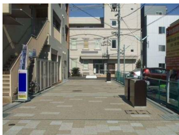
電線共同溝整備工事
