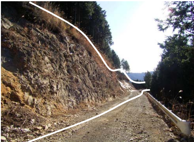
林道竹ノ沢線(法面吹付工)
