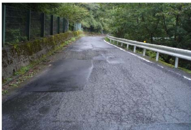
県道井川湖御幸線(葵区口坂本)舗装打ち換え
