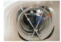
下水道管の耐震工事の様子
