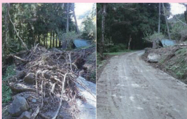
台風15号で被災した施設の早期復旧に係る費用として活用しました。(写真左：被災直後 写真右：復旧後)
