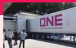
ドックシェルターの様子
