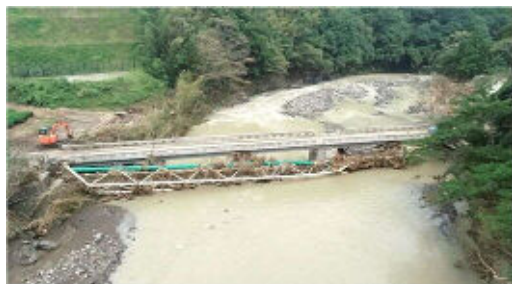
宮嶋橋水管橋（和田島地区）
