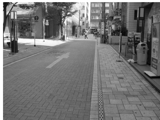
道路と段差のない歩行者空間
