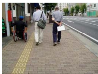
横断及び縦断勾配 がきつい
