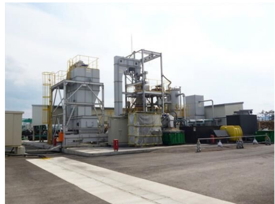
東日本大震災 二次仮置場におけるバイオマス発電利用
