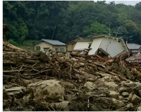
平成 26 年 8 月豪雨 宅地に流入した土砂・流木等 写真出典：災害廃棄物対策フォトチャンネル ( http://kouikishori.env.go.jp/photo_channel/ ) の画像を加工（トリミング）して掲載
