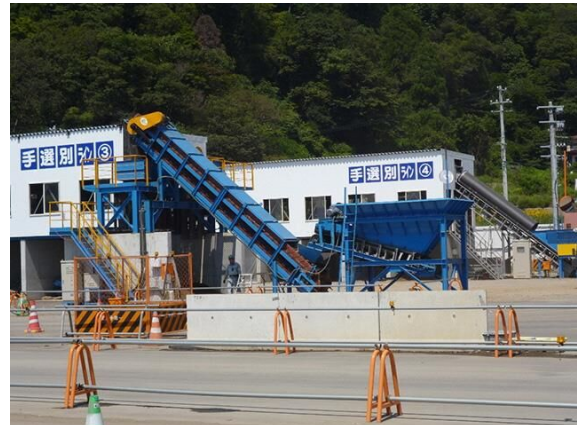
二次仮置場に設置された手選別ライン
