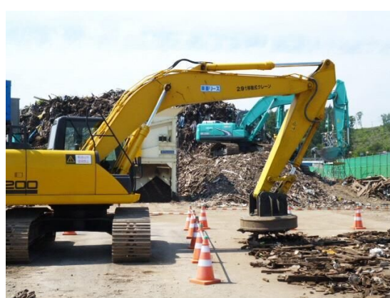
重機を活用した選別処理
