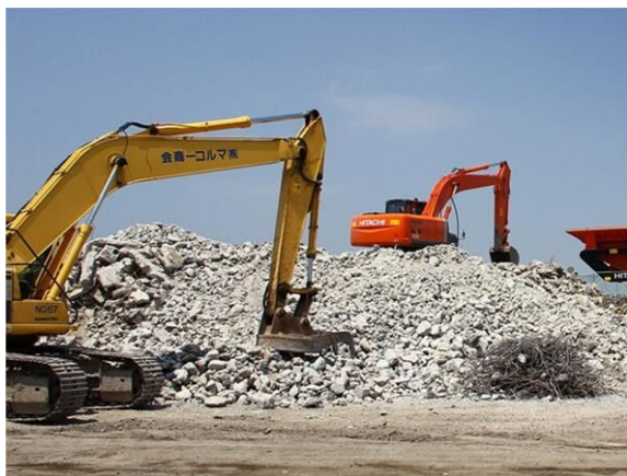
東日本大震災で発生したコンクリートがら
