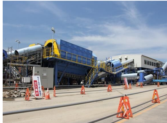
東日本大震災 二次仮置場
