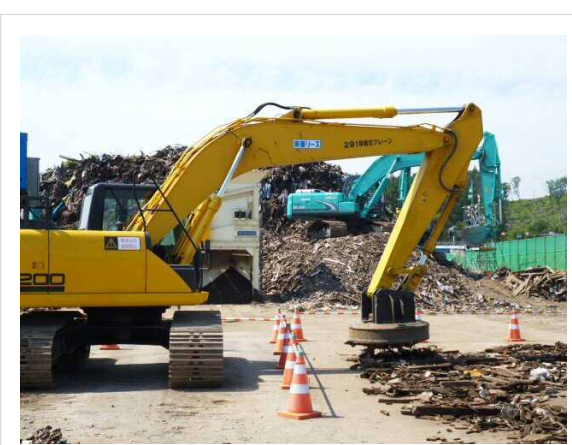
重機を活用した選別処理
