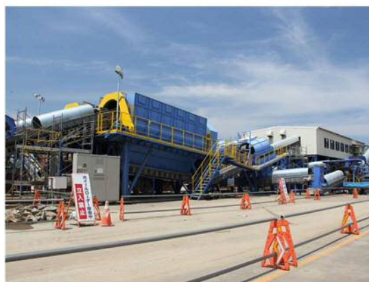
東日本大震災 二次仮置場
