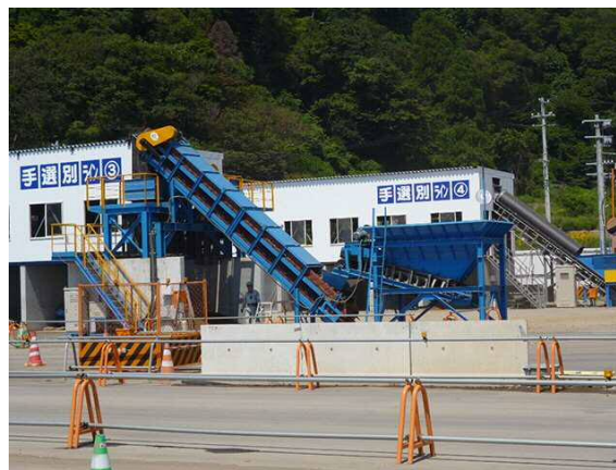
二次仮置場に設置された手選別ライン
