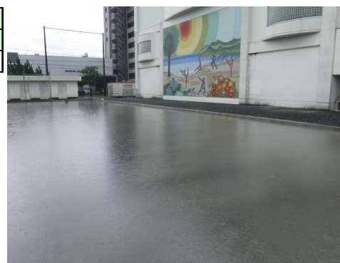
雨水貯留浸透施設の状況 (豊田中学校 令和3年8月撮影)
