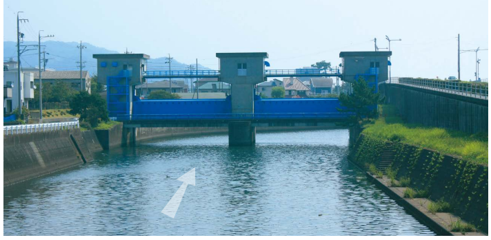
上流から水門を望む
