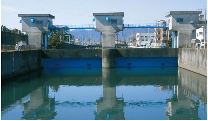
水門閉鎖訓練
