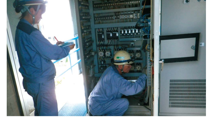
電機設備点検
