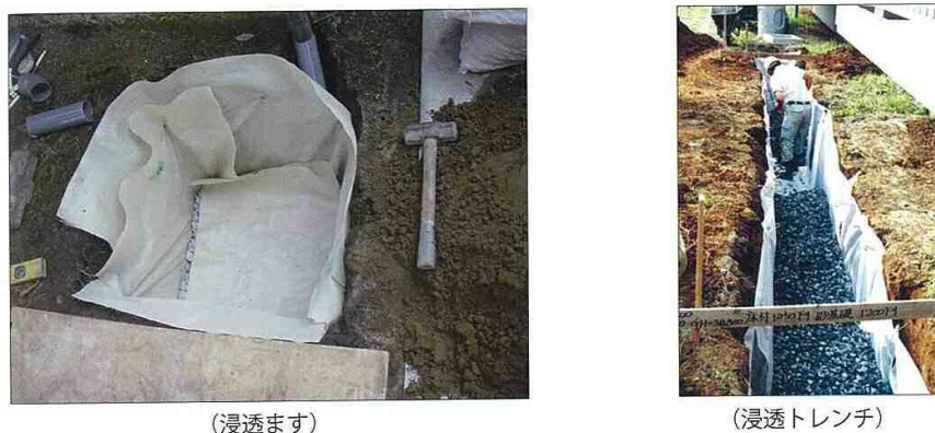
図 7-5 充填砕石の施工
