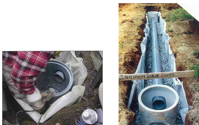
図 7-6 浸透ます、透水管の据付
