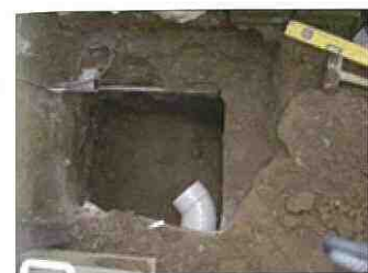
図 7-2 掘削状況 (浸透ます)
