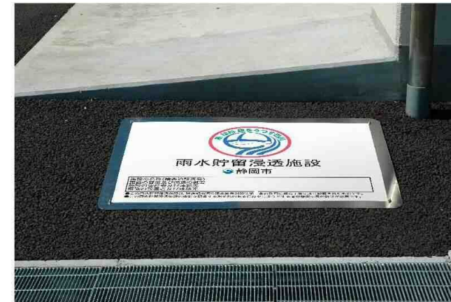
図 6-25 設置状況のイメージ（透水性舗装）
