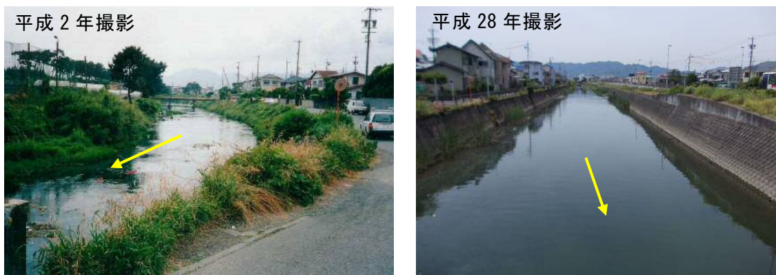
図 2-4 治水事業完成区間の状況（西前橋より上流を望む）
