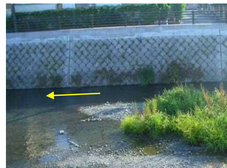
図 4-18 環境護岸の実施箇所
