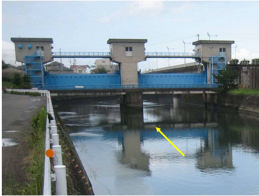
図 2-8 浜川水門 (H 元. 3 完成)
