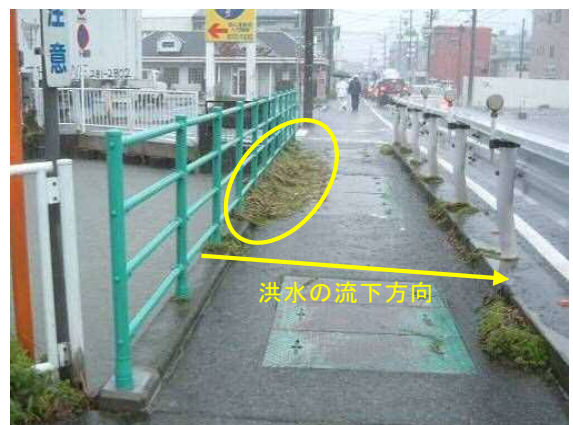
③浜川念仏橋の溢水状況
