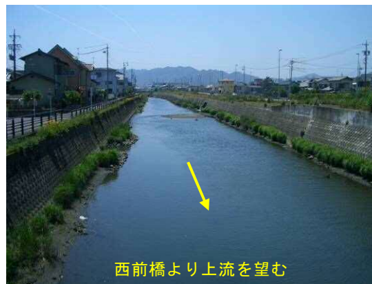
図 2-18 下流部の河道状況
