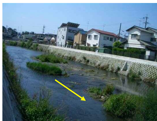
図 1-25 浜川上流 -護岸整備箇所-
