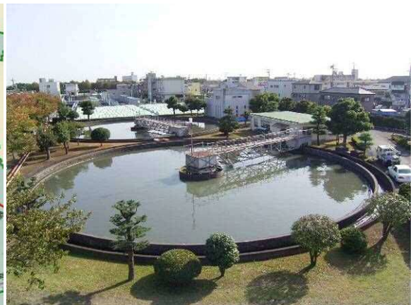
図 2-16 高松浄化センター
