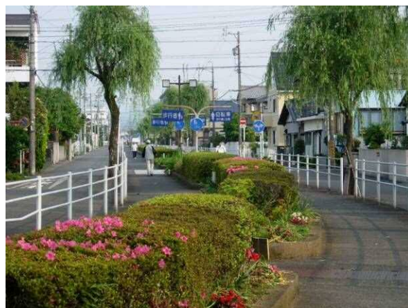
図 2-13 下水道暗渠部の歩行者道及び自転車道
