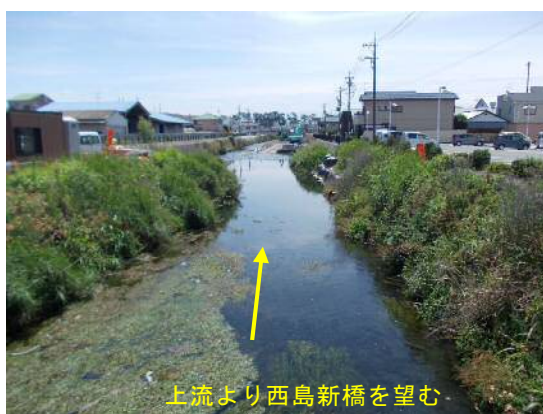
図 2-22 上流部の河道状況
