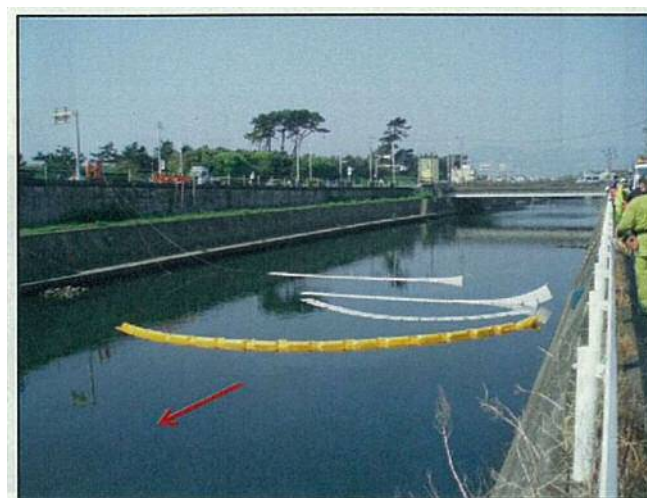
図 2-17 水質事故の対応 (オイルフェンス・オイルマットの設置)
