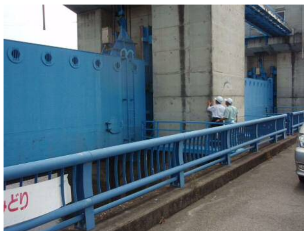
図 4-21 浜川水門の点検状況
