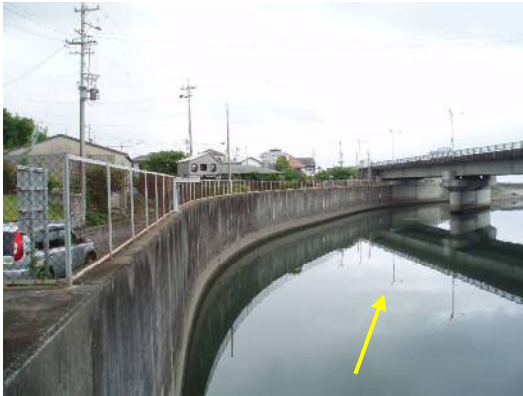
図 1-27 特殊堤 (浜川左岸：津波対策)
