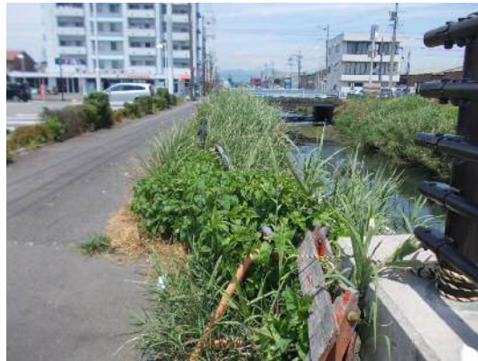
図 4-4 護岸の未整備箇所 (1.82km～1.875km (念仏橋) 下流付近)
