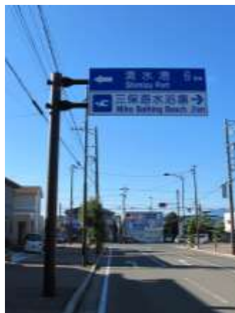
道路標識のうち、経路案内標識はF型(道路張り出し型)を基本として設置します(静岡市)
