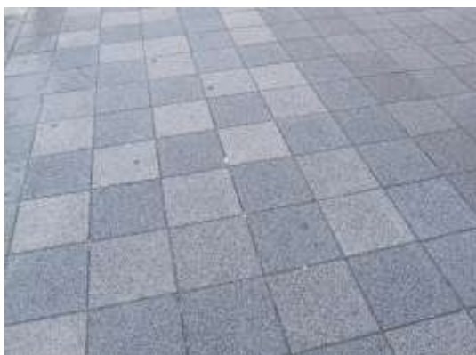
同様の色相で、異なる複数の明度の舗装材を組み合わせることで、汚れが目立たないようにしています(名古屋市)
