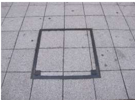
正方形の平板舗装材をマンホールの蓋に埋め込むことで、途切れのない、一体性を出しています(静岡市)
