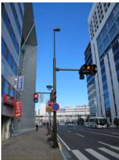
ダークブラウンの道路照明灯に信号機と道路標識を統合することで、すっきりした景観になっています(静岡市)
