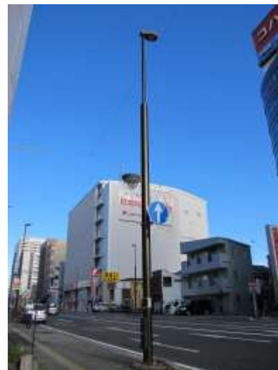
歩道照明に道路標識を統合することで、余分な支柱の設置を軽減しています(静岡市)
