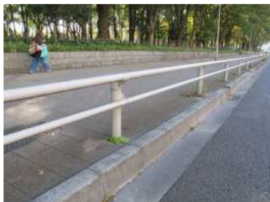
ベージュを用いることで、周囲の景観に融和しています(名古屋市)
