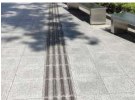
視覚障害者誘導用ブロックと路面をグレーの濃淡で敷設することで、輝度比を確保しています(千代田区丸の内)
