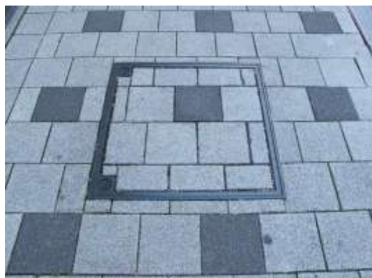
2色の平板舗装材を上手くマンホールの蓋に埋め込むことで、連続した敷設パターンを確保しています(静岡市)
