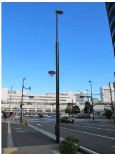
直線型で、かつ灯具の出幅が少ない形状を用いることで、周囲の景観を阻害していません(静岡市)
