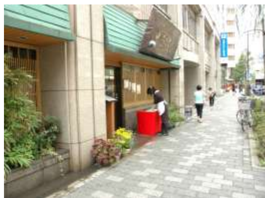
無彩色の、異なる複数の明度の舗装材を組み合わせることで、周囲の景観を引き立てます(千代田区丸の内)
