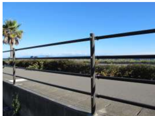
細い支柱や横桟を用いることで、開放感のある景観となっています(静岡市)
