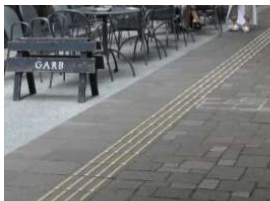
視覚障害者誘導用ブロックの凸部のみを黄色にして、輝度比を確保しながら目立ちにくくしています(千代田区丸の内)
