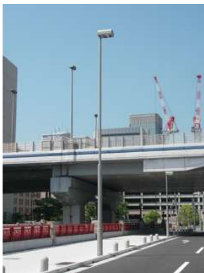
支柱を細く、形状をシンプルにすることで、背景を大きく阻害していません(神戸市)
