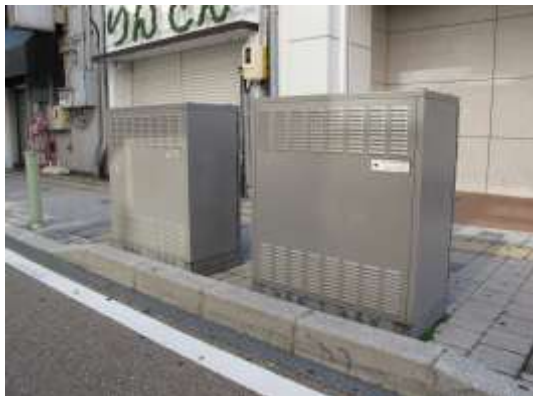
グレーページを用いることで、周囲のまち並みに融和しています(静岡市)
