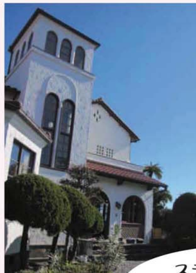
出入口の様子
