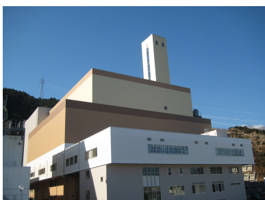
▼西ヶ谷清掃工場
