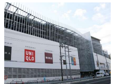
通りに面して表情のあるデザインとなっている駐車場階の目隠しルーバー
