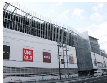
通りに面して表情のあるデザインとなっている駐車場階の目隠しルーバー*
