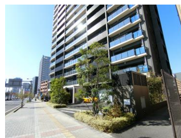
敷地内の道路から見える位置への緑化
