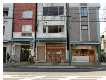
日よけテント（オーニング）のデザインの統一により、商店街の連続性を創出
