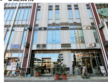
ガラス面を多く設け、開放的なデザインとなっている低層部
