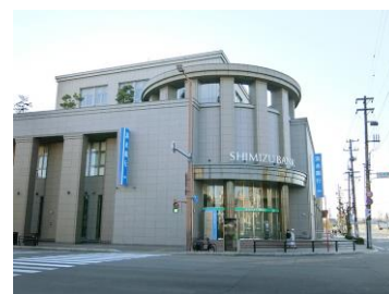
外壁のデザインにより沿道への圧迫感を軽減
