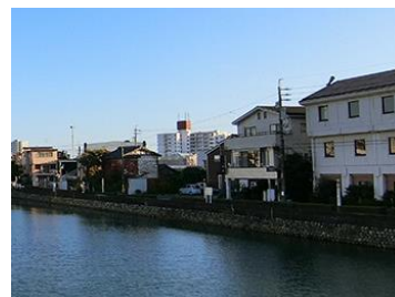
川に対して窓など開口部を設けている建築物
