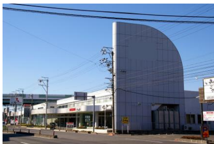
ロードサイドショップが建ち並ぶ幹線道路沿道
