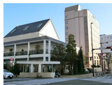
中高木の植栽により、街路樹と一体となって緑の空間を創出
