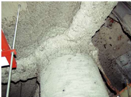
鉄骨の柱・梁
