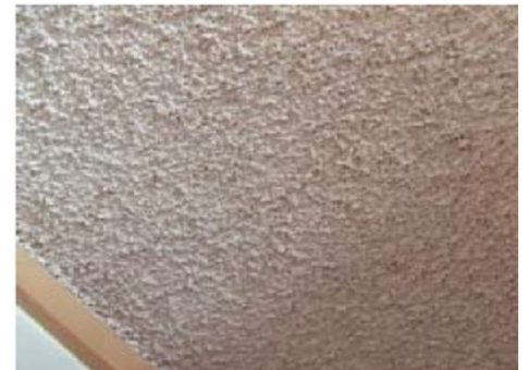
吹付けバーミキュライト （ひる石吹付け）
