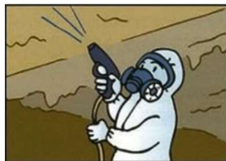
封じ込め工法
