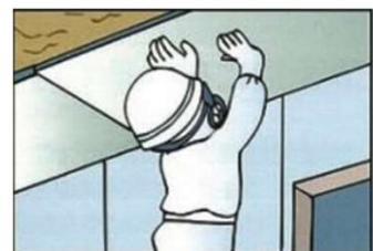
囲い込み工法
