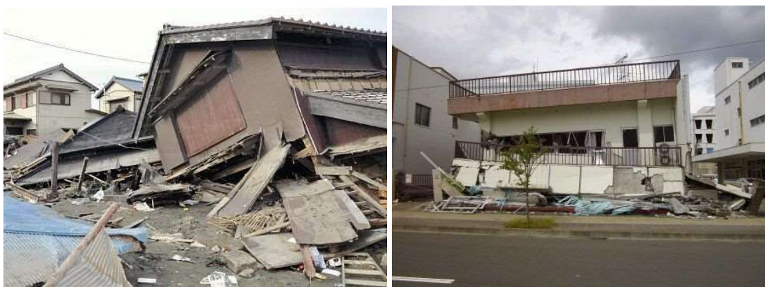
東日本大震災による建物の被害状況（平成 23 年 3 月 11 日）
