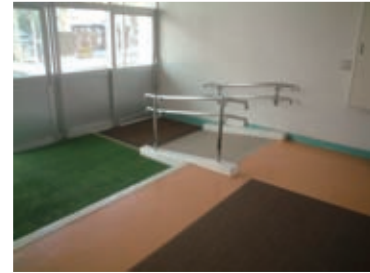
既存施設にスロープ、手摺、防滑を施す。
