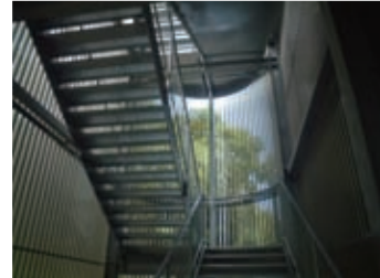
仕上げを考慮し耐久性を向上させる。
