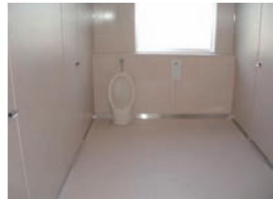
（城東保健福祉エリア）女子トイレ内に 男児用便器を設置し母子での使用に配慮
