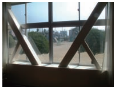
既存建築物の耐震補強対策
