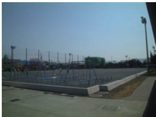
小学校グラウンドの貯留式による雨水流出抑制
