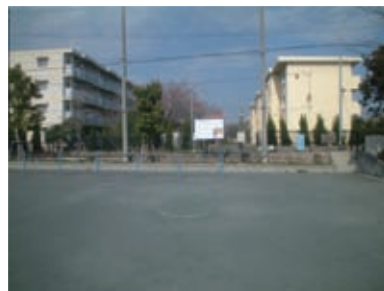
小学校グラウンドに埋設された 非常用貯水槽（1万人3日分）
