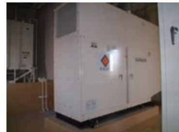
非常時の確実な稼動（発電機）の為に、定期的な点検、燃料の確認を行う。
