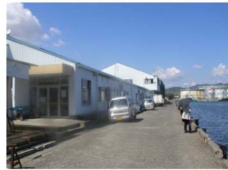
海側に背を向けて立地する施設（水際を活用すれば、より水辺らしいにぎわいが形成できる）
