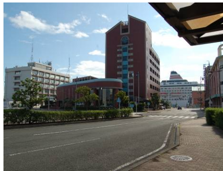
業務車両等が利用するドリプラとマリンターミナルを結ぶ道路
