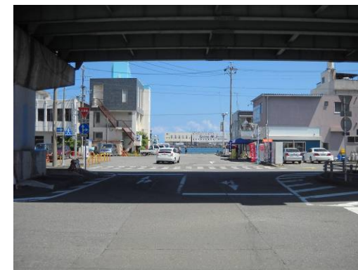
臨港線跡遊歩道が不連続のため、来訪者等歩行者の横断が危険である
