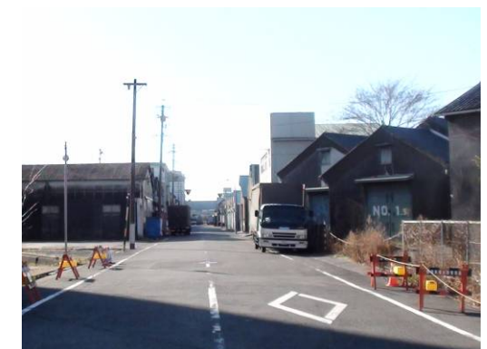
石積み倉庫周辺では倉庫で荷卸するトラックが多く、歩行者には危険である
