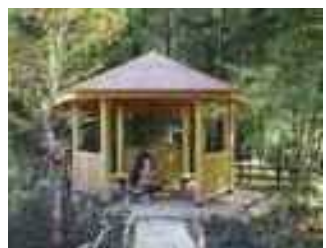
休憩施設の設置
