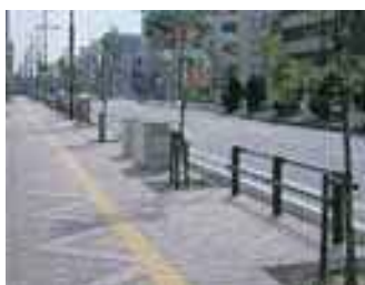
歩道の修景整備
