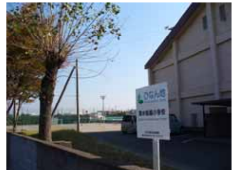
広域避難地（清水船越小学校）
