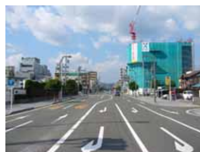
延焼遮断帯としての道路整備
