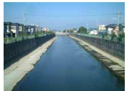
大谷川放水路
