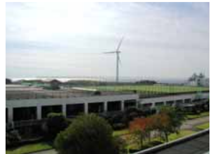
中島下水処理場
