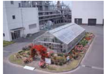
中島下水処理場
