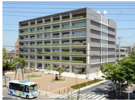
バルコニーと柱によるグリッドで立面を構成した事例 ／みよし市庁舎(愛知県)
