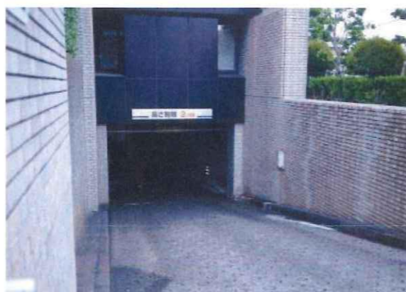
地下への車路（浸水の懸念大）
