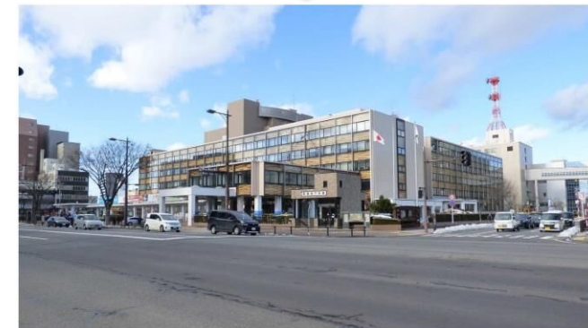
改修後の県庁舎（出所：青森県資料より）
