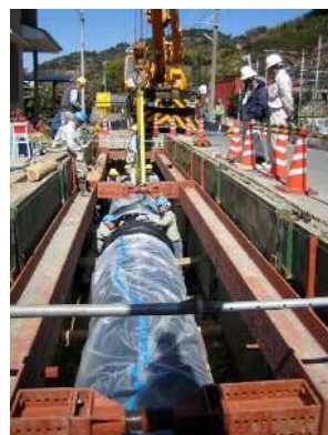
老朽管布設替工事状況
