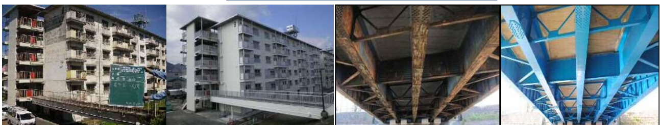
市営住宅の長寿命化（施工前・後）
