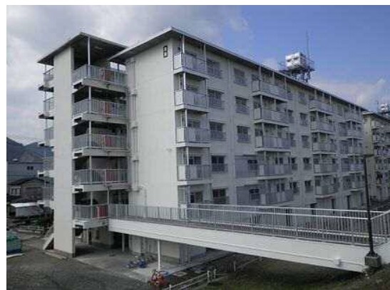
市営住宅の長寿命化（施工後）
