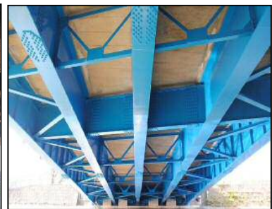
道路橋梁の長寿命化（施工後）
