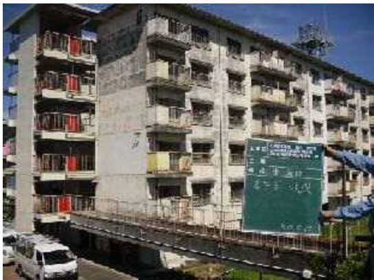
市営住宅の長寿命化（施工前）
